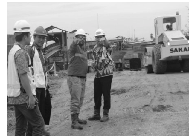
Gambar 5.4 Tampak dibelakang tim, truk mengantar muatan batubara ke stockpile karena conveyer belum maksimal berfungsi
