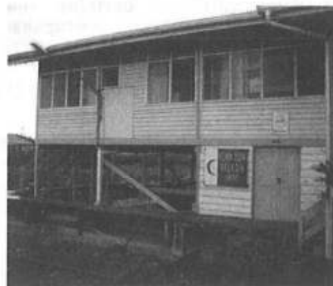
Klinik Desa di Kampung Beladin, Pusa, Sarawak, yang dilawat SUHAKAM pada bulan Februari 2008.
